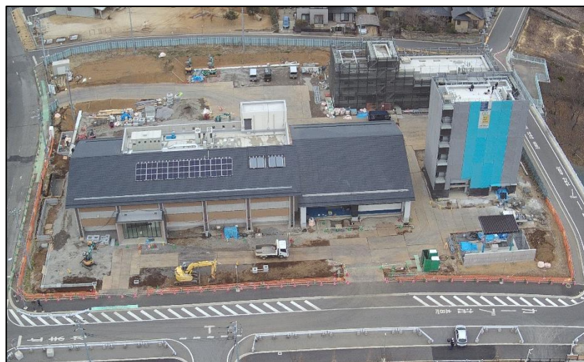
工事の様子(消防庁舎) (令和8年2月10日撮影)
