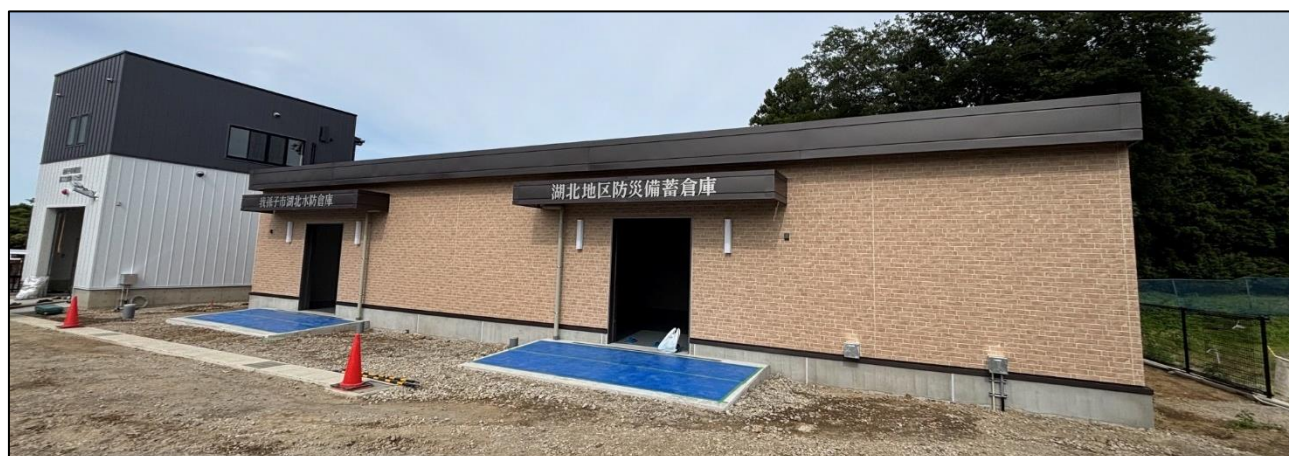
湖北地区防災備蓄倉庫(R8.6.16 時点)
