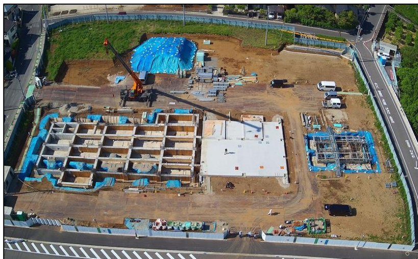
工事の様子(消防庁舎) (令和7年5月8日撮影)
