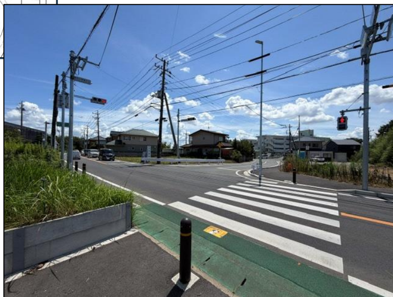
布佐小学校入口交差点 (工事完了後)
