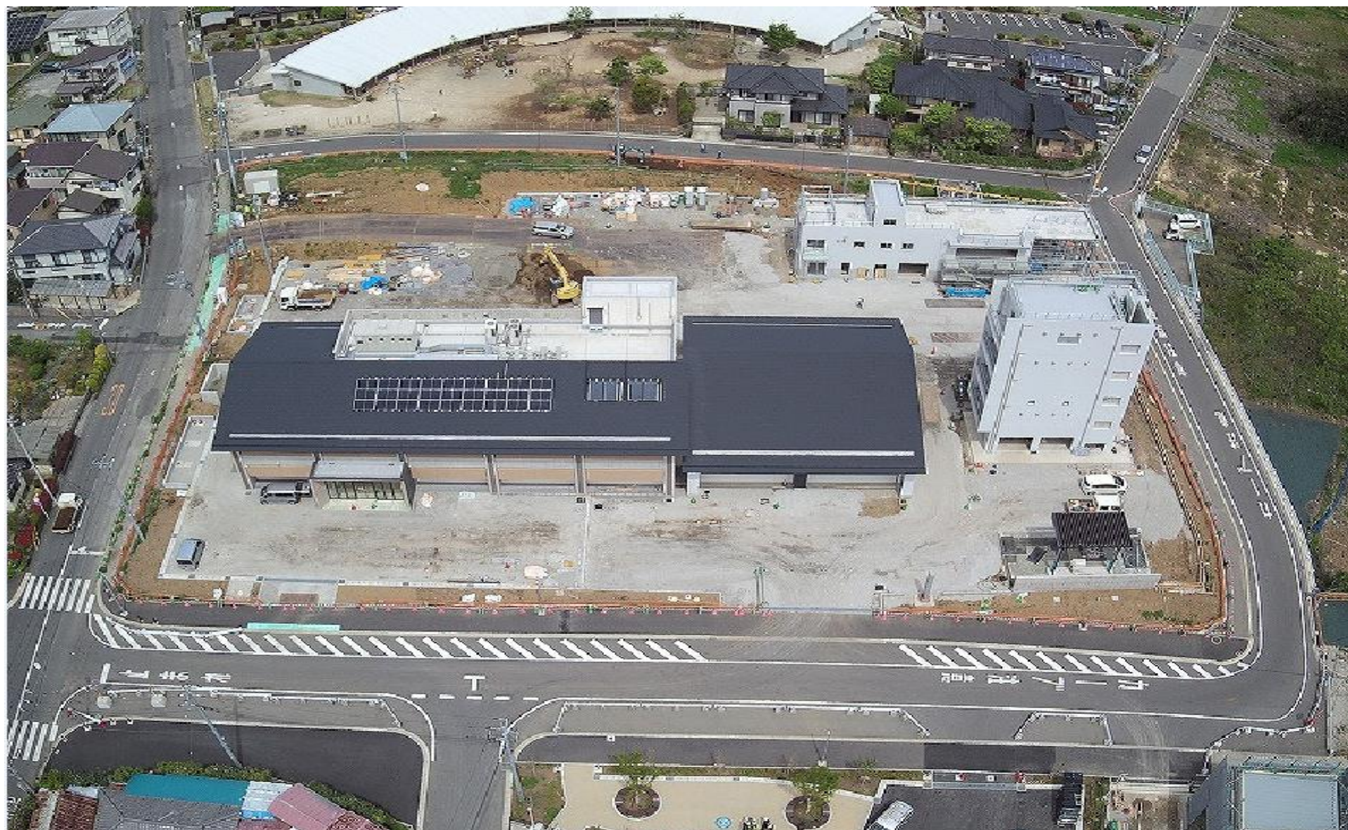
湖北消防署庁舎整備工事外観
