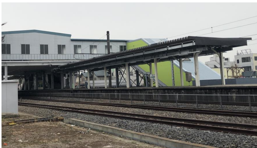
▲完成した湖北駅ホーム屋根
