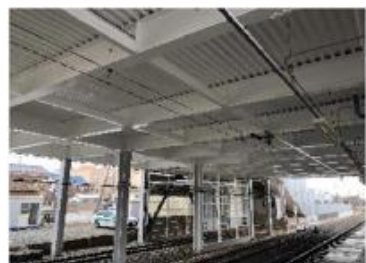
▲塗装修繕した橋上下部
