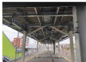
▲完成した湖北駅ホーム屋根（ホーム上）
