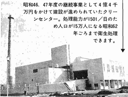
昭和46. 47年度の継続事業として4億4千万円をかけて建設が進められていたクリーンセンター。処理能力が150t/日のため人口が15万人になる昭和62年ころまで衛生処理できます。
