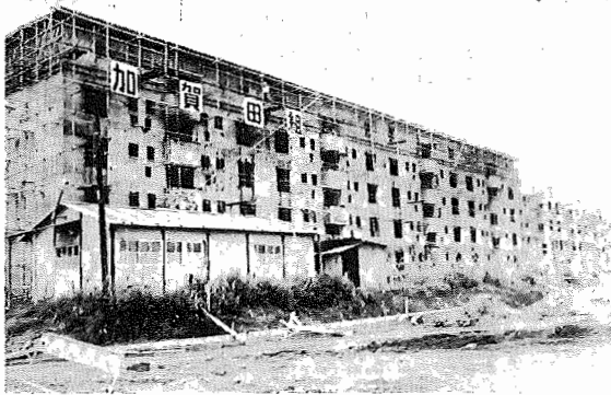
建設中の5階建ての賃貸住宅
