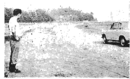
都部新田地先の都市計画街路1部完成 都市計画街路の第231号道路として、都部新田地先に4月初旬工事に着手しましたが、このほど一部が完成しました。幅員は12メートル、延長約1.5キロメートルです。
