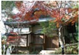
洋風建築の新館
