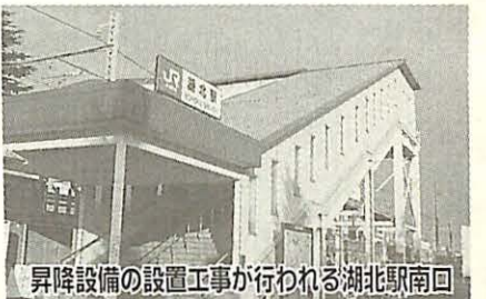
昇降設備の設置工事が行われる湖北駅南口
