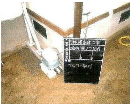
【写真7】ブロー設置状況を示す写真
