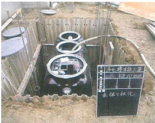
【写真 4】据付工事の状況を示す写真
