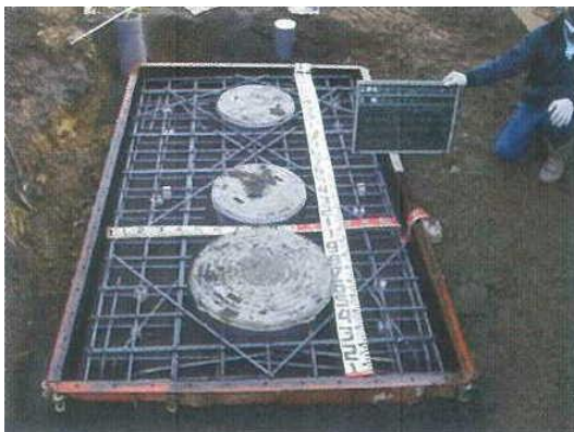
【写真6】上部スラブ工事を示す写真
