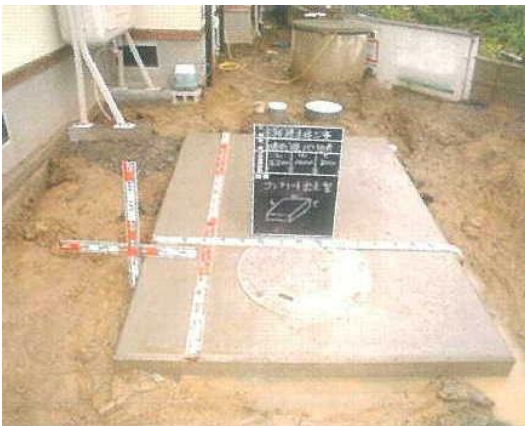
【写真7】ブロー設置状況を示す写真
