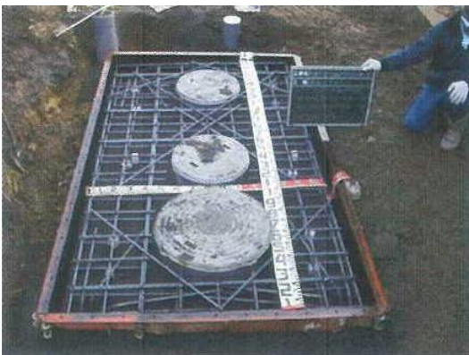
【写真6】上部スラブ工事を示す写真
