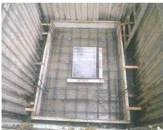
【写真 2-3】 基礎工事の配筋状況を示す写真
