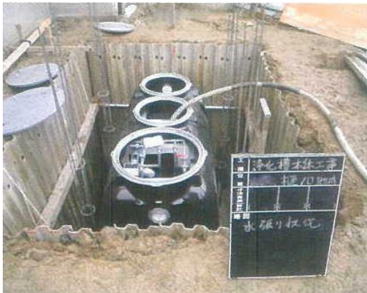
【写真 4】据付工事の状況を示す写真
