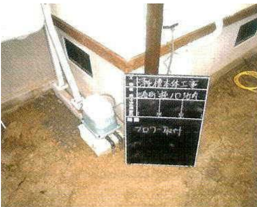
【写真7】ブロー設置状況を示す写真
