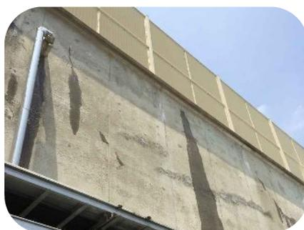
図 5-3.湖北台浄水場ろ過原水ポンプ井漏水跡
