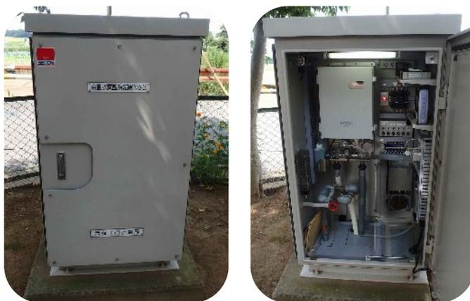
図 3-5.連続自動水質監視装置(外側・内部)
