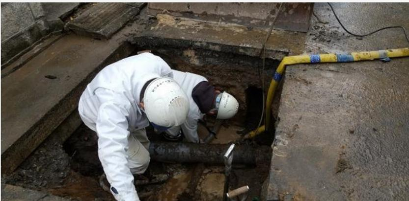
塩化ビニル管の破損による漏水(令和6年1月 並木)
