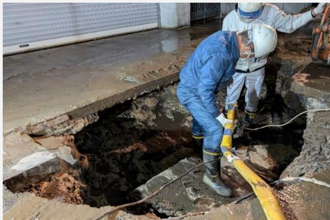
塩化ビニル管の破損による漏水(令和7年2月 若松)
