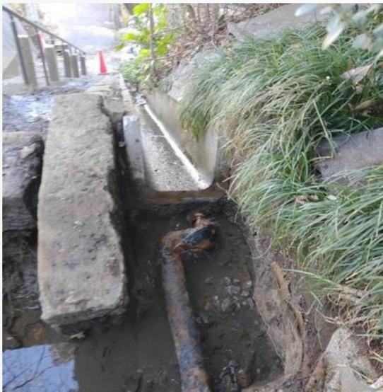
鋼管の破損による漏水(令和6年1月 寿)
