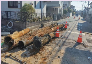
▲老朽化した水道管
