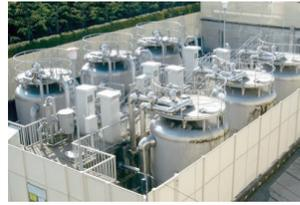
内部に生物活性炭が充填されています。オゾン処理水を通させることにより、オゾン処理で分解した有機物などを取り除きます。
