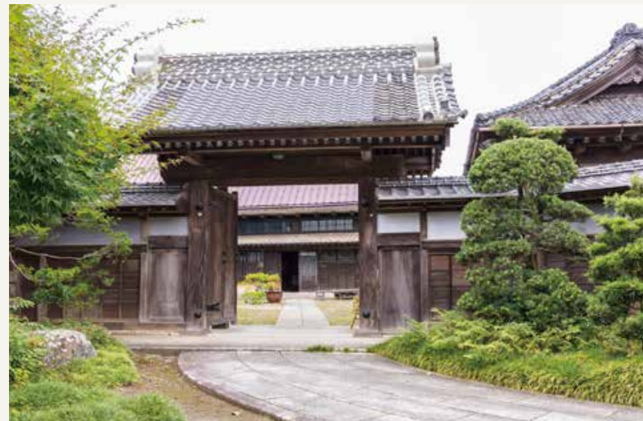
修復された表門。当時の瓦や柱も活かし、足らない部材のみ新調した。意匠の細かさは必見。
