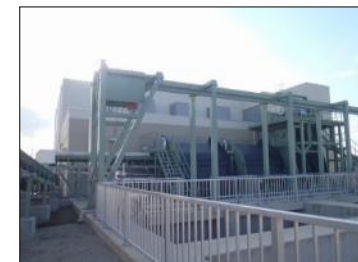
布佐ポンプ場完成
