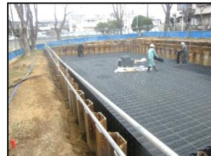
暫定貯留浸透施設(施工時)
