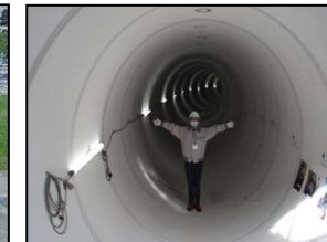
整備後の状況(管路内部)
