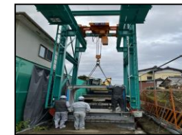
雨水幹線施工状況
