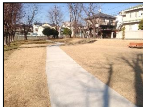
施設地上部(完成後)
