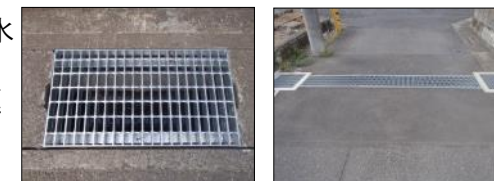
緊急対策 (グレーチング蓋)
