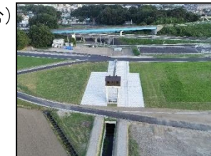
後田樋管(整備後)
