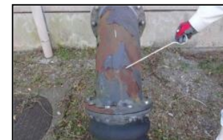
雨水ポンプ吐出口(施工前)
