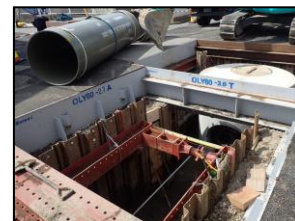
雨水管布設工事
