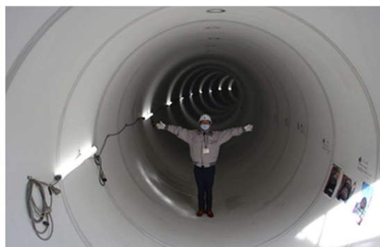
整備後の状況 (管路内部 φ3000mm)
