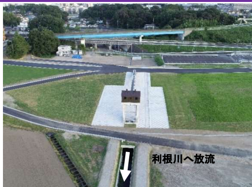
後田樋管 (整備済み)
