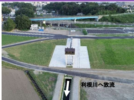
後田樋管（整備済み）
