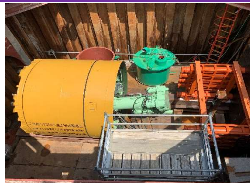
雨水幹線整備工事（推進工事）の状況
