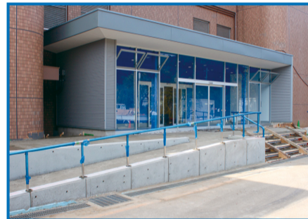
▲水の館北側 農産物直売所の入口(工事中)
