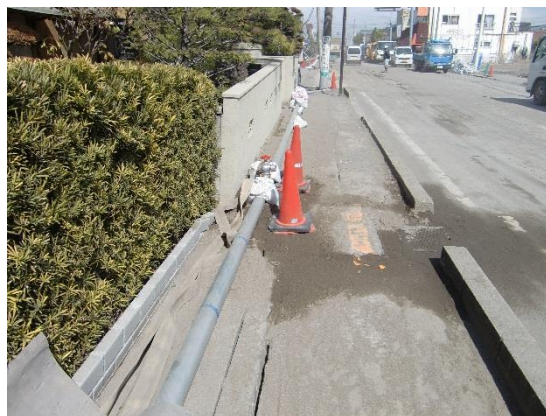
応急復旧による仮設配水管路
