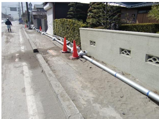
応急復旧による仮設配水管路
