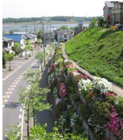
▲高低差の大きい擁壁を緑化ブロックとすることにより、圧迫感を軽減するとともに、手賀沼への眺望にも配慮しています。(高野山)
