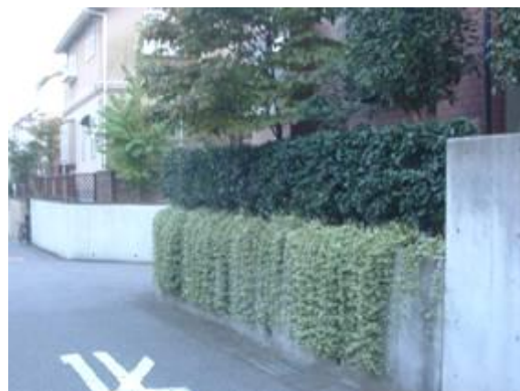
▲擁壁につる性植物を組み合わせることにより、印象をやわらげています。(栄)
