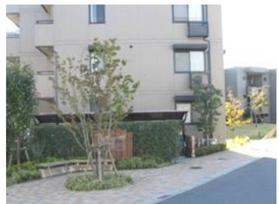
▲ポケットパークを確保するとともに、駐輪場を緑で修景しています。(天王台4丁目)
