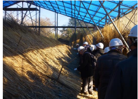
葺き替え中の屋根
