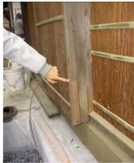
現在までに2つの発見がありました。ひとつはトイレ外側の舟板壁です。舟板壁は和船の部品を解体して壁に使うという、趣味的なもので、村川堅固の嗜好を示すものとして注目できるものでしたが、傷みが激しく、どのようにしようか悩みどころでした。大工さんがうまく壊れないように板を剥がし
