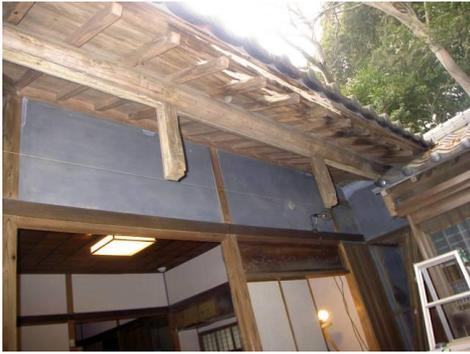
予め工場で切り込まれた（あるいは仮組みされた）部材を現場で組み立てるだけとなり、このような技術自体が極めて貴重となっています。また大工さんが腐朽した部材の形状を設計図もないのに写し取って、そっくり同じものを新材で作りました箇所もあります。
