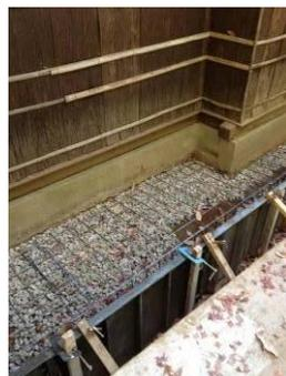
土壌流出が著しく、礎石下の栗石や配管がむき出しになっていました。また跳ね上がった雨土が土台や柱、壁を濡らし、腐朽を進行させていたのです。
