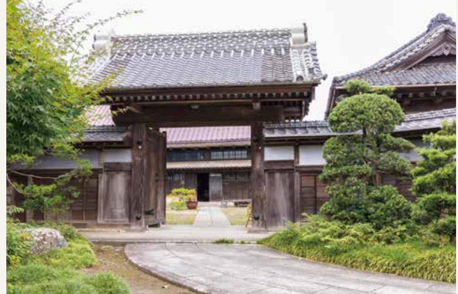
修復された表門。当時の瓦や柱も活用し、足りない部材のみ新調した。意匠の細かさは必見。
