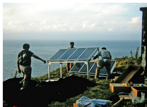
音声再生装置のためのソーラーパネルの設置作業
