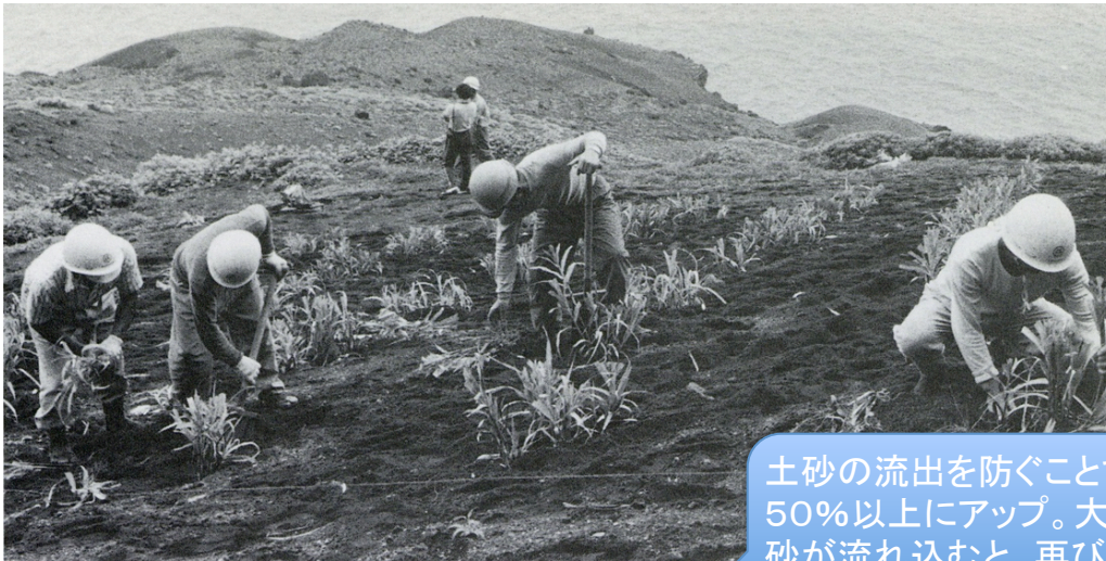
土砂流出を防ぎ土壌を安定させるため、ハチジョウススキが移植されました。 (1981年6月) (撮影:長谷川 博) (提供:フレーベル館)
