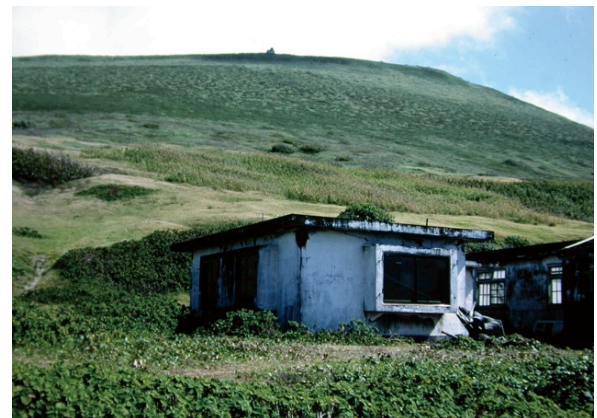
はつねざき 初寝崎の地表は植生で覆われている(建物は旧気象観測所)
