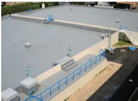
▲湖北台浄水場配水池
