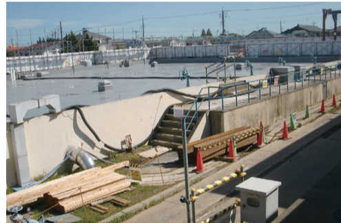
▲湖北台浄水場(配水池)
