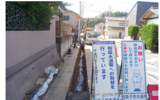
▲高機能ダクタイル鉄管埋設状況
