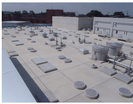
▲生物活性炭吸着池屋上
