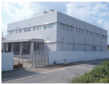
▲オゾン処理施設 (オゾン棟)
