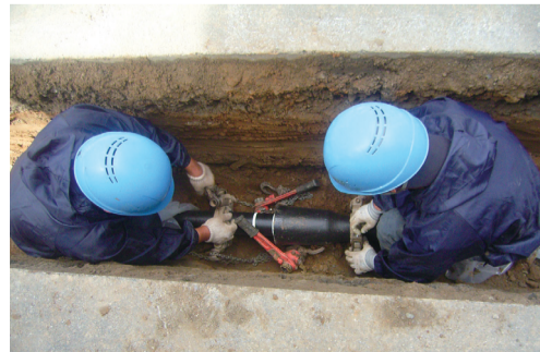
▲高機能ダクタイル鉄管接合状況
