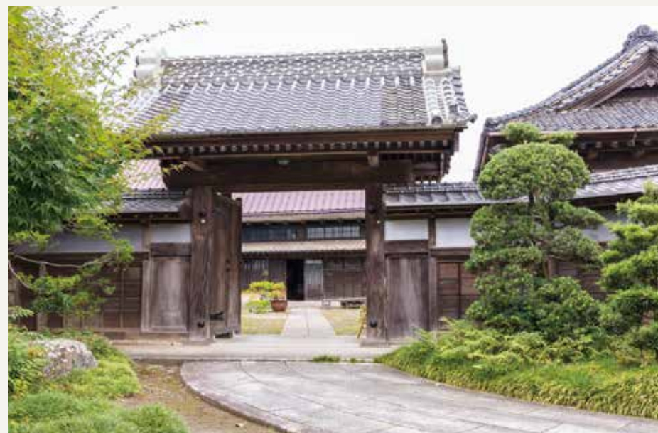
修復後的正門。運用當時的瓦片和柱子，祇對殘缺部分進行了換新。其設計之細緻精巧，值得觀賞。
